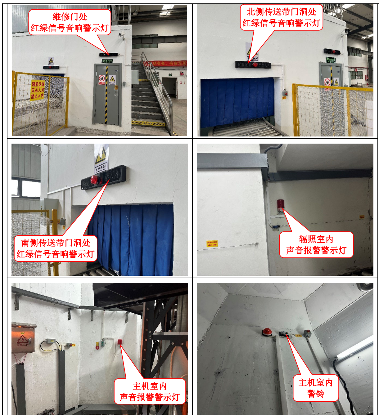
图 3-4 各红绿信号音响警示灯、声音报警警示灯、警铃
