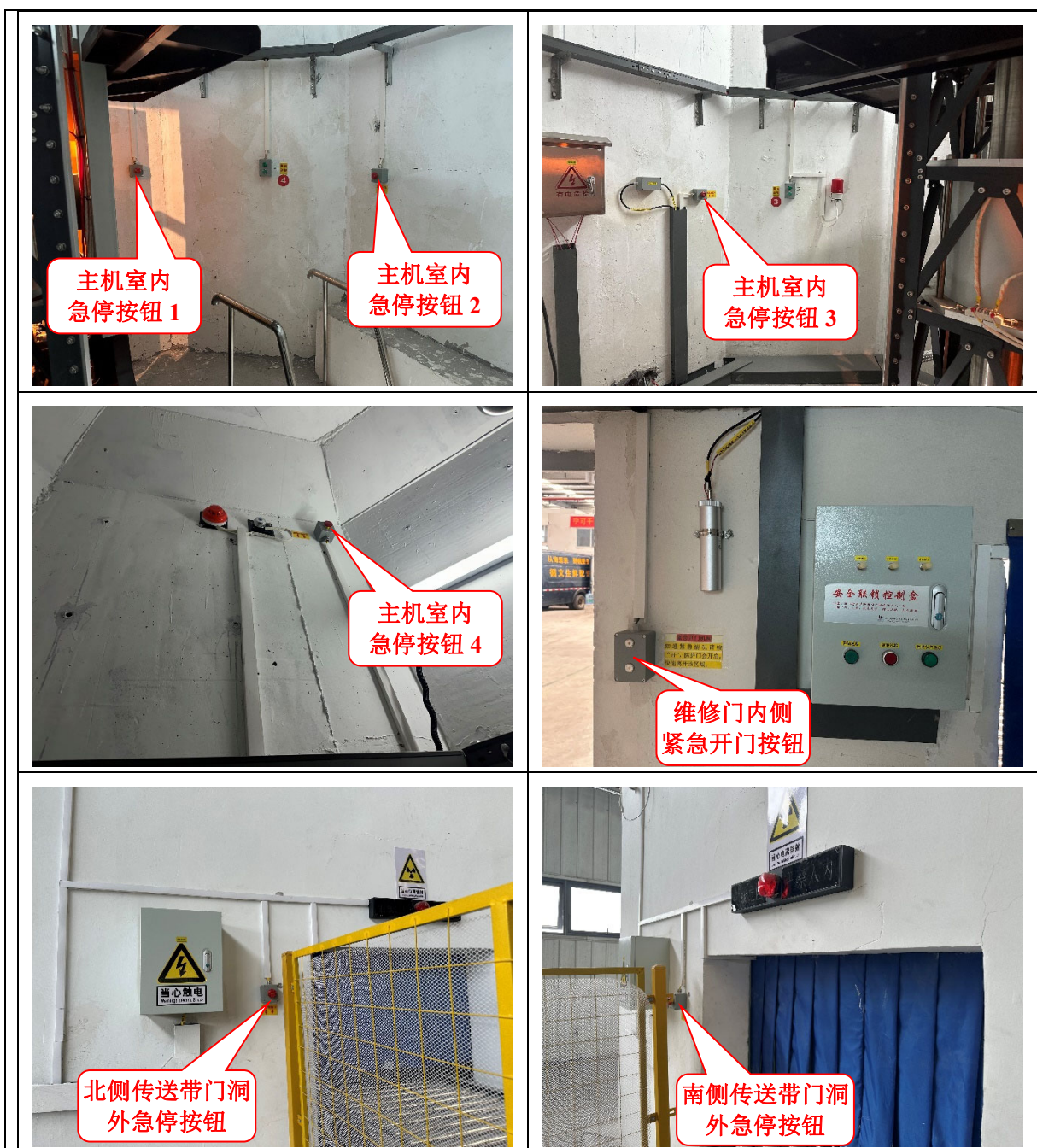
图 3-7 急停按钮和急停拉绳开关
