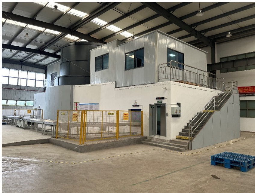
图 2-1 本次竣工环保验收的辐照加速器机房
