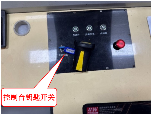
图 3-2 加速器控制室主控台钥匙开关
