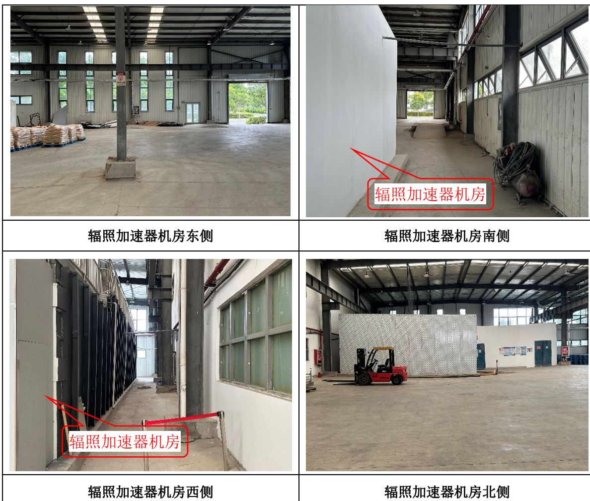
图 2-2 本次竣工环保验收的辐照加速器机房周围环境
