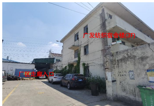
走廊入口处西侧的广发纺织宿舍楼
