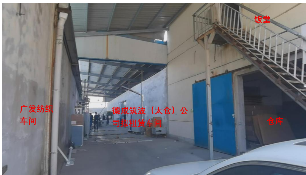
从西侧走廊入口看走廊及生产厂区现状
