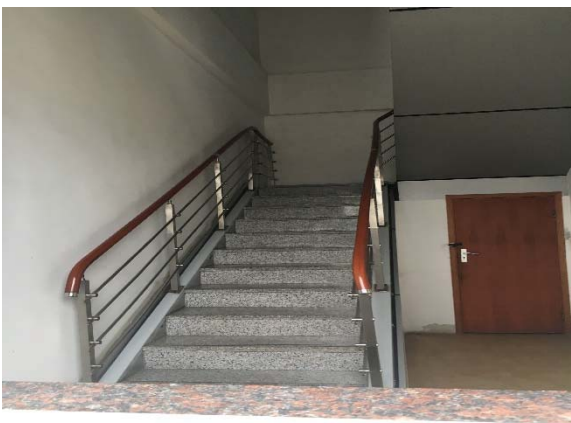
图 8-2 探伤铅房拟搬迁场址东侧楼梯间
