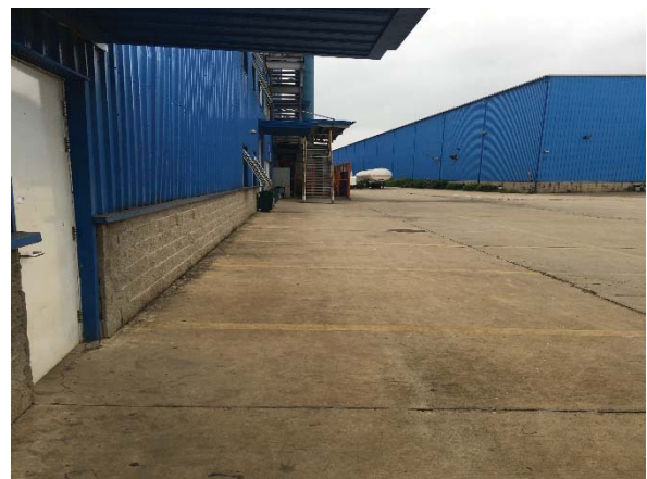
图 8-3 探伤铅房拟搬迁场址南侧公司道路
