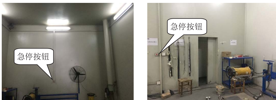
图 10-1 本项目拟搬迁的 IMC 探伤铅房现有的辐射安全措施
