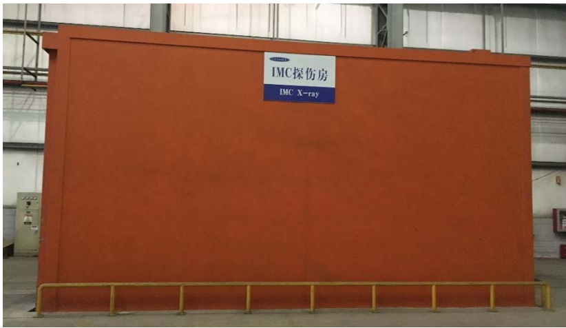
图 9-1 本项目 IMC 探伤铅房外观图
