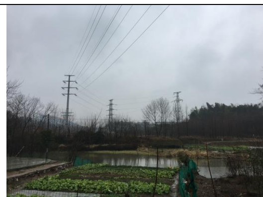
跨越青通河支流处恢复情况
