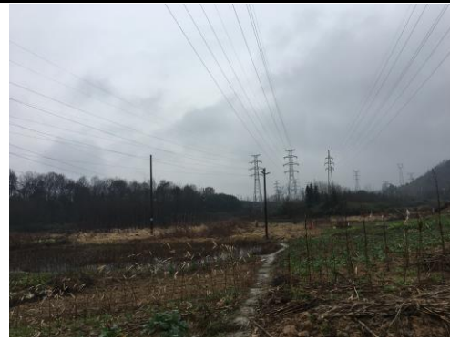
线路走廊的恢复情况
