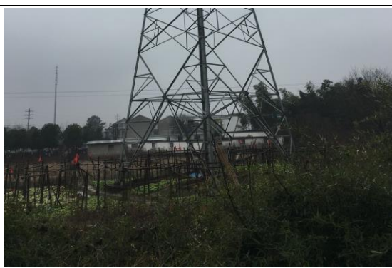
塔基恢复情况
