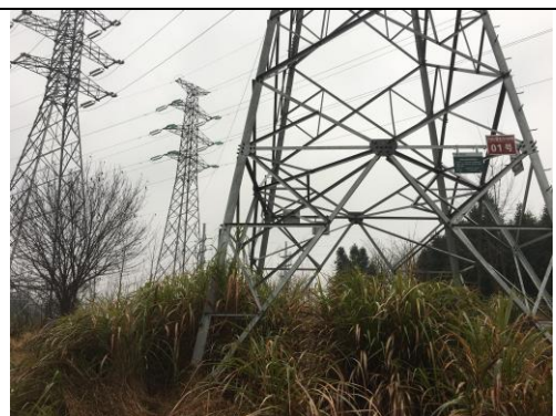
塔基恢复情况
