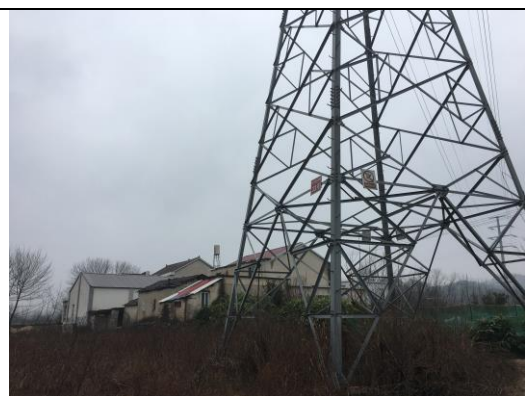
塔基恢复情况
