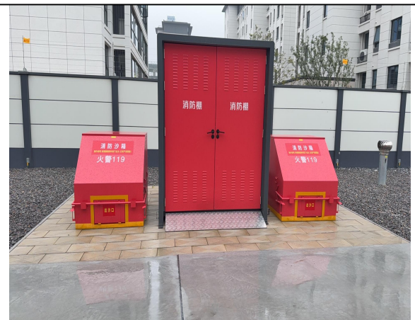
滨河 110kV 变电站消防设施
