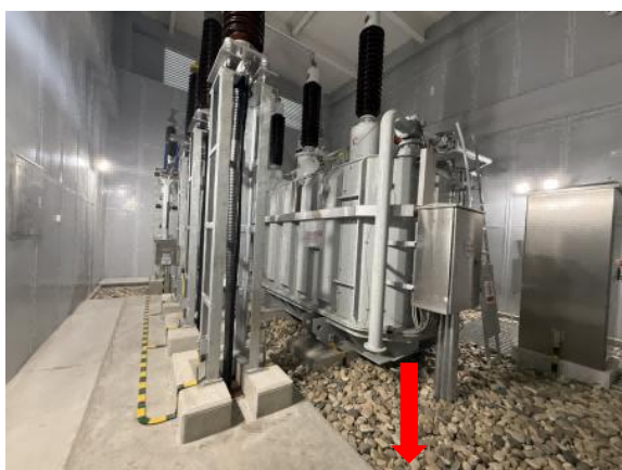
滨河 110kV 变电站#1 主变及下方事故油坑
