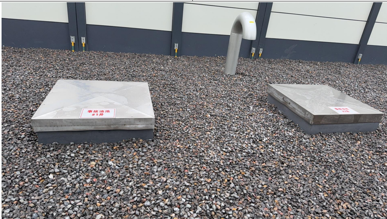
滨河 110kV 变电站事故油池
