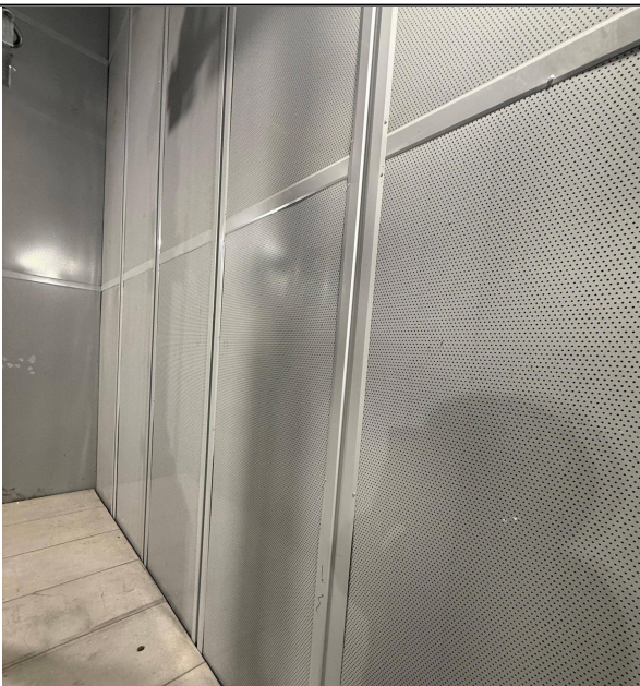
主变室微孔吸声墙
