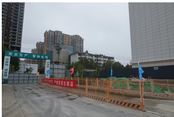
施工围挡及钢板铺设
