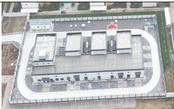
变电站地面硬化和砂石化
