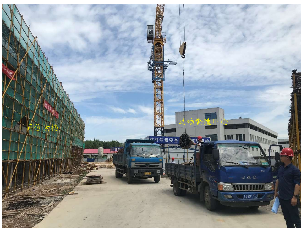
图 8-1 拟建同位素楼现状
