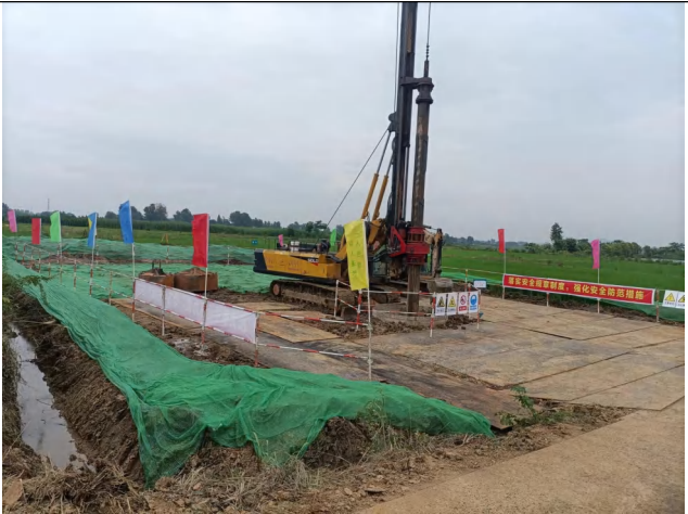
临时苫盖、施工围挡、铺设钢板
