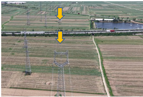
跨越场生态恢复
