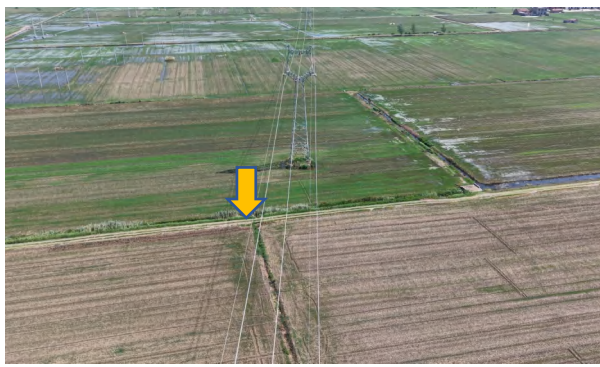
施工道路区生态恢复
