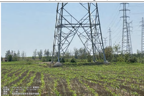
塔基生态恢复（蟠岳 27Q2 线#67）
