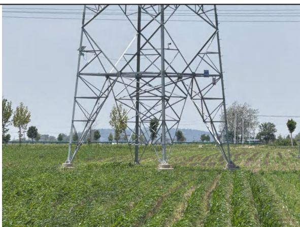
塔基生态恢复（蟠岳 27Q2 线#58）
