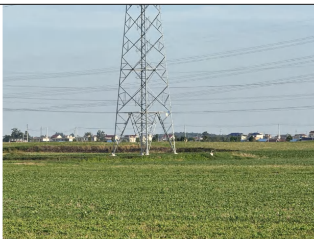
塔基生态恢复（蟠岳 27Q2 线#19）
