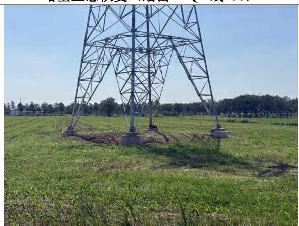
塔基生态恢复（虹岳 27Q1 线#64）
