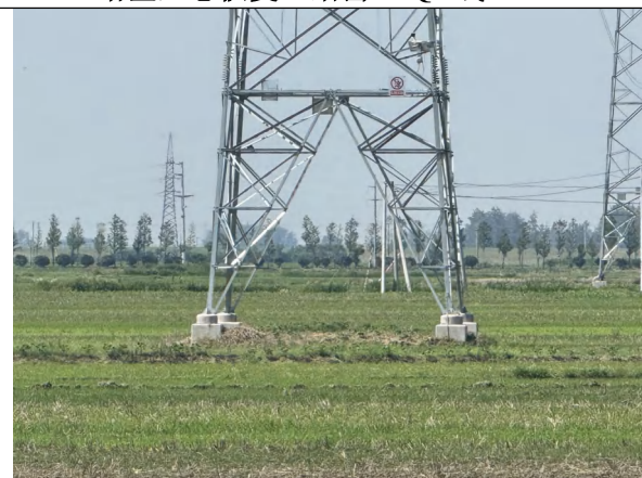
塔基生态恢复（虹岳 27Q1 线#53）
