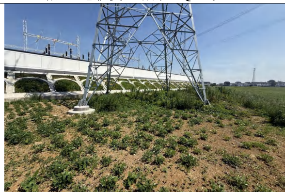
塔基生态恢复（蟠岳 27Q2 线#87）
