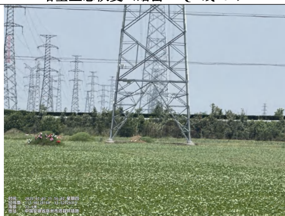
塔基生态恢复（蟠岳 27Q2 线#66）
