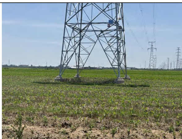
塔基生态恢复（蟠岳 27Q2 线#62）
