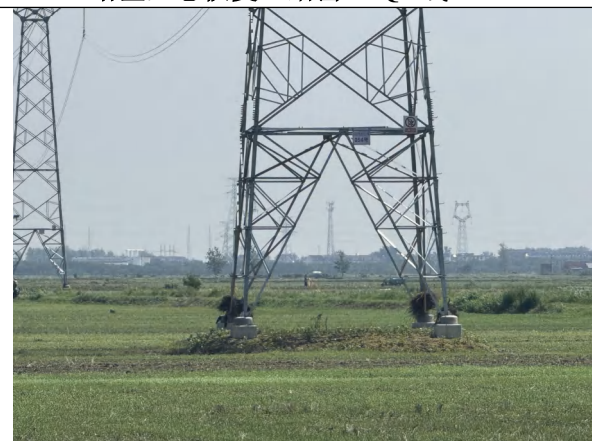
塔基生态恢复（虹岳 27Q1 线#54）
