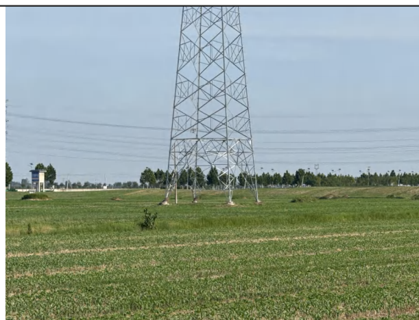
塔基生态恢复（蟠岳 27Q2 线#24）
