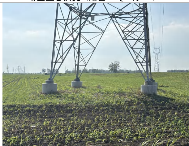
塔基生态恢复（蟠岳 27Q2 线#39）
