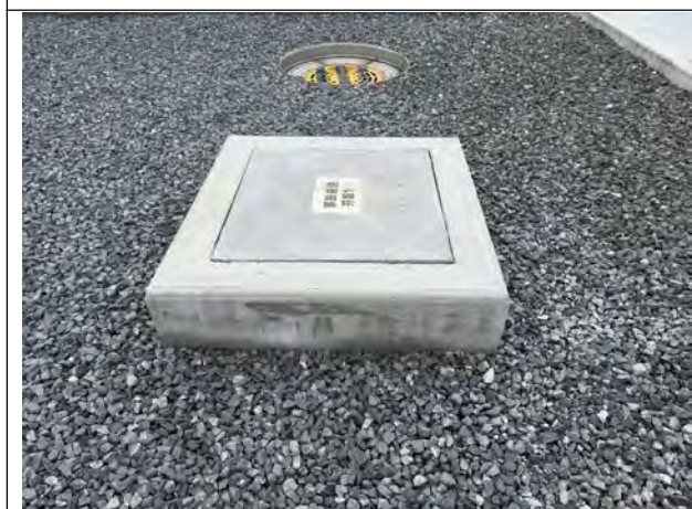
抬阁 110kV 变电站事故油池
