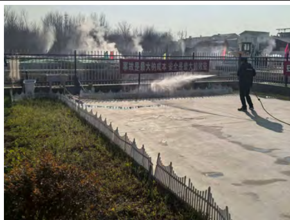
施工围挡水喷淋降尘及人工洒水抑尘
