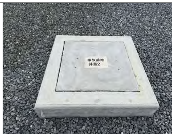
抬阁 110kV 变电站事故油池
