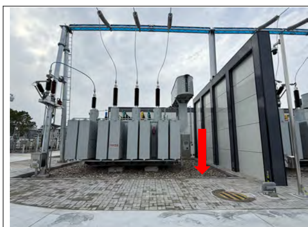
抬阁 110kV 变电站#1 主变及下方事故油坑
