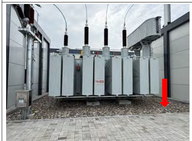
抬阁 110kV 变电站#2 主变及下方事故油坑
