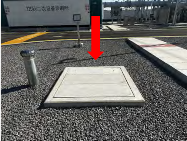
芳园 220kV 变电站事故油池 (有效容积 76m 3 )
