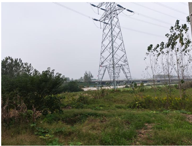
220kV 肖真 4H15/4H16 线 35#杆塔周围生态恢复 （“仪征市红山风景名胜区”生态空间管控区域内）
