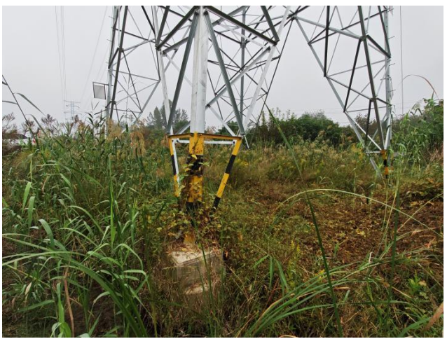
220kV 肖真 4H15/4H16 线 36#杆塔周围生态恢复 （“仪征市红山风景名胜区”生态空间管控区域内）
