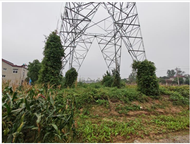
220kV 肖真 4H15/4H16 线 39#杆塔周围生态恢复 （“仪征市红山风景名胜区”生态空间管控区域内）
