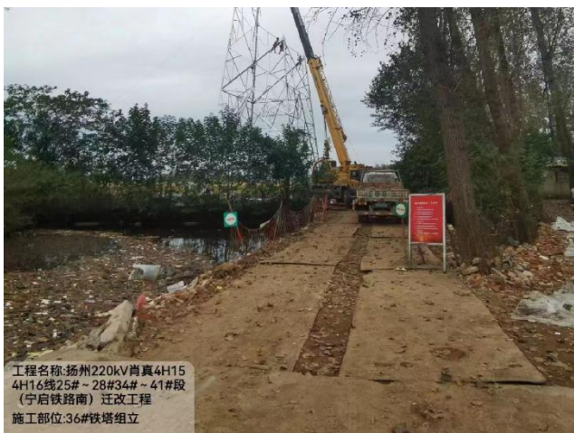
施工临时道路铺设钢板（一）
