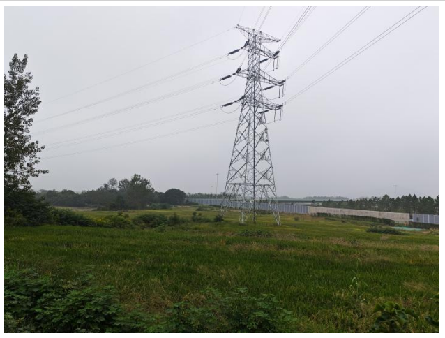
220kV 肖真 4H15/4H16 线 40#杆塔周围牵张场复耕 （“仪征市红山风景名胜区”生态空间管控区域内）
