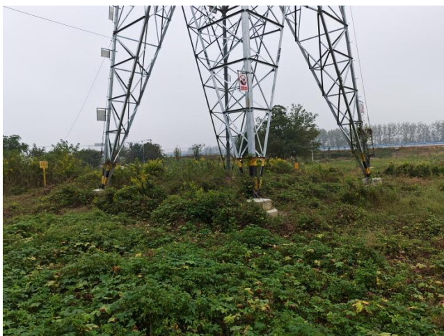
220kV 肖真 4H15/4H16 线 37#杆塔周围生态恢复 （“仪征市红山风景名胜区”生态空间管控区域内）
