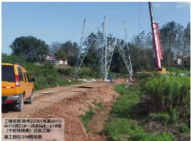
施工临时道路铺设钢板（二）
