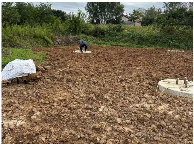
杆塔周围土地整治（二）
