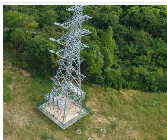
110kV 六集 762 线 031 号塔基处生态恢复
