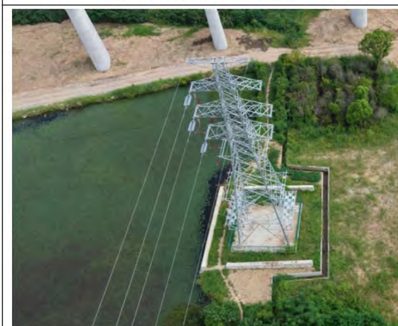
110kV 六姚 765 线 032 号塔基处生态恢复
