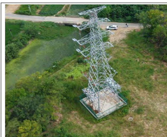
110kV 六姚 765 线 031 号塔基处生态恢复
