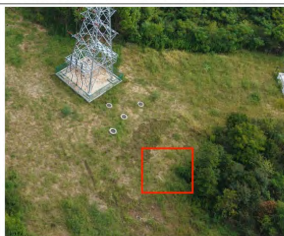
原六集线#31 拆除塔基处生态恢复
