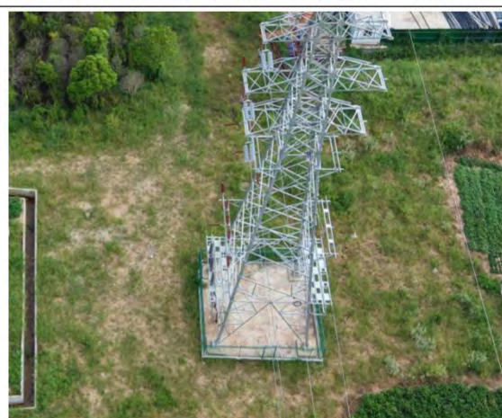
110kV 六集 762 线 032 号塔基处生态恢复
