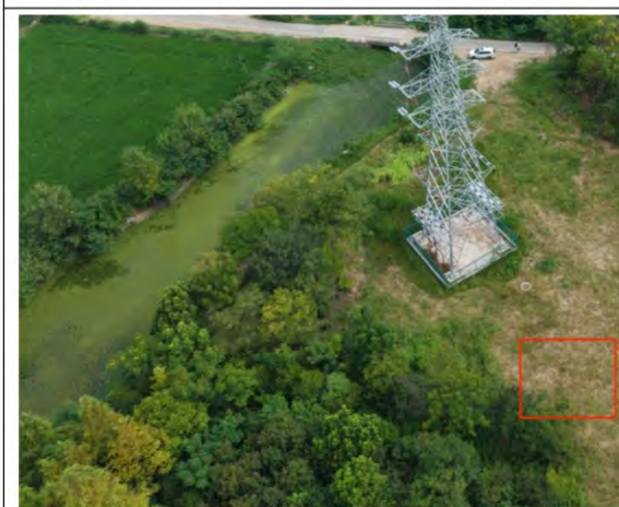
原六姚线#31 拆除塔基处生态恢复
