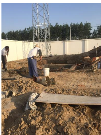
污水处理装置
